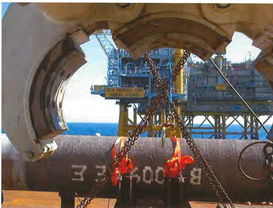
Selv med moderne teknologi er reparasjon av rørledninger under vann fremdeles avhengig av dykkere.
