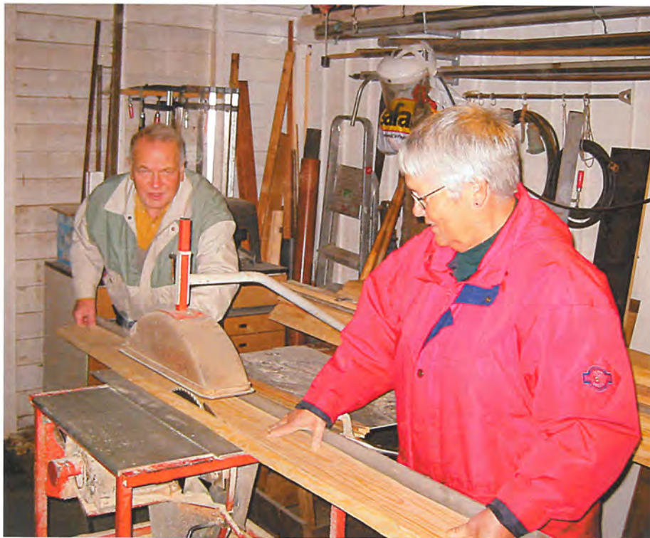
Saging av innvendig kledning.
