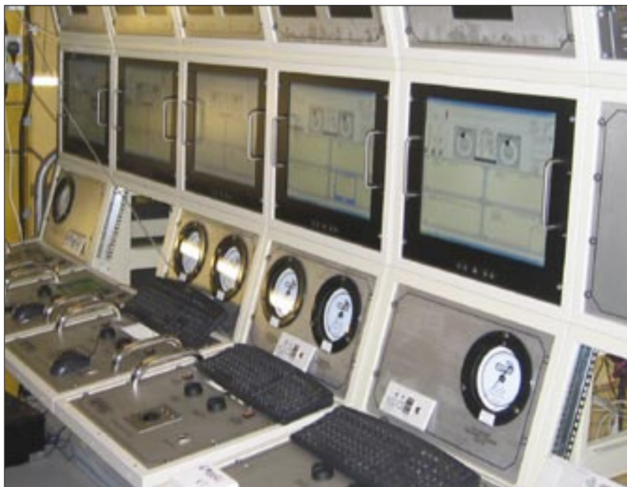
Flatskjermer og 'tracker balls' erstatter ventiler og manometre
