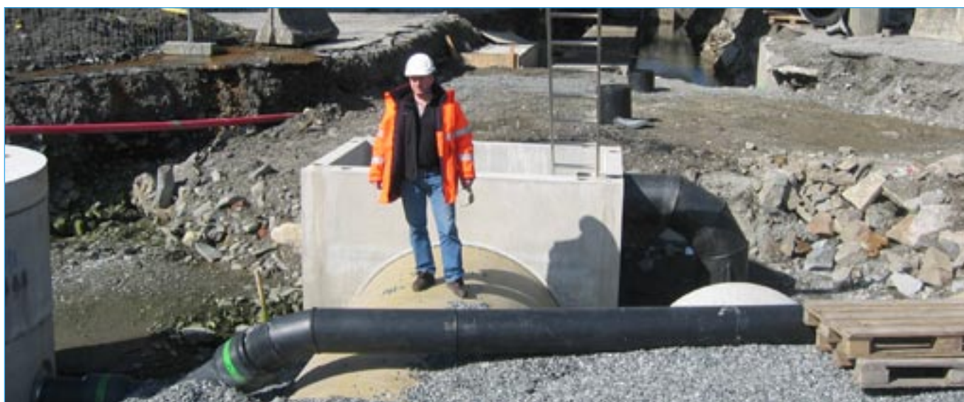
Starten på den nye overvannsledningen.
