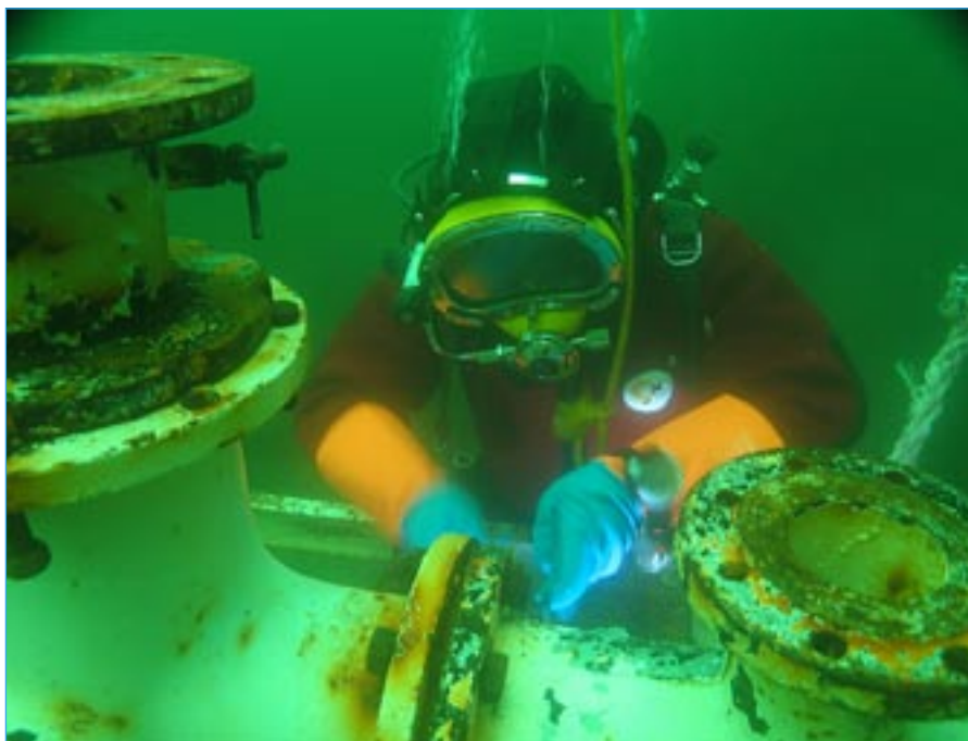
Student i konstruksjonsarbeid
