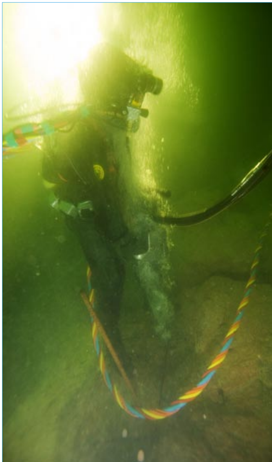
Boring i fjell
