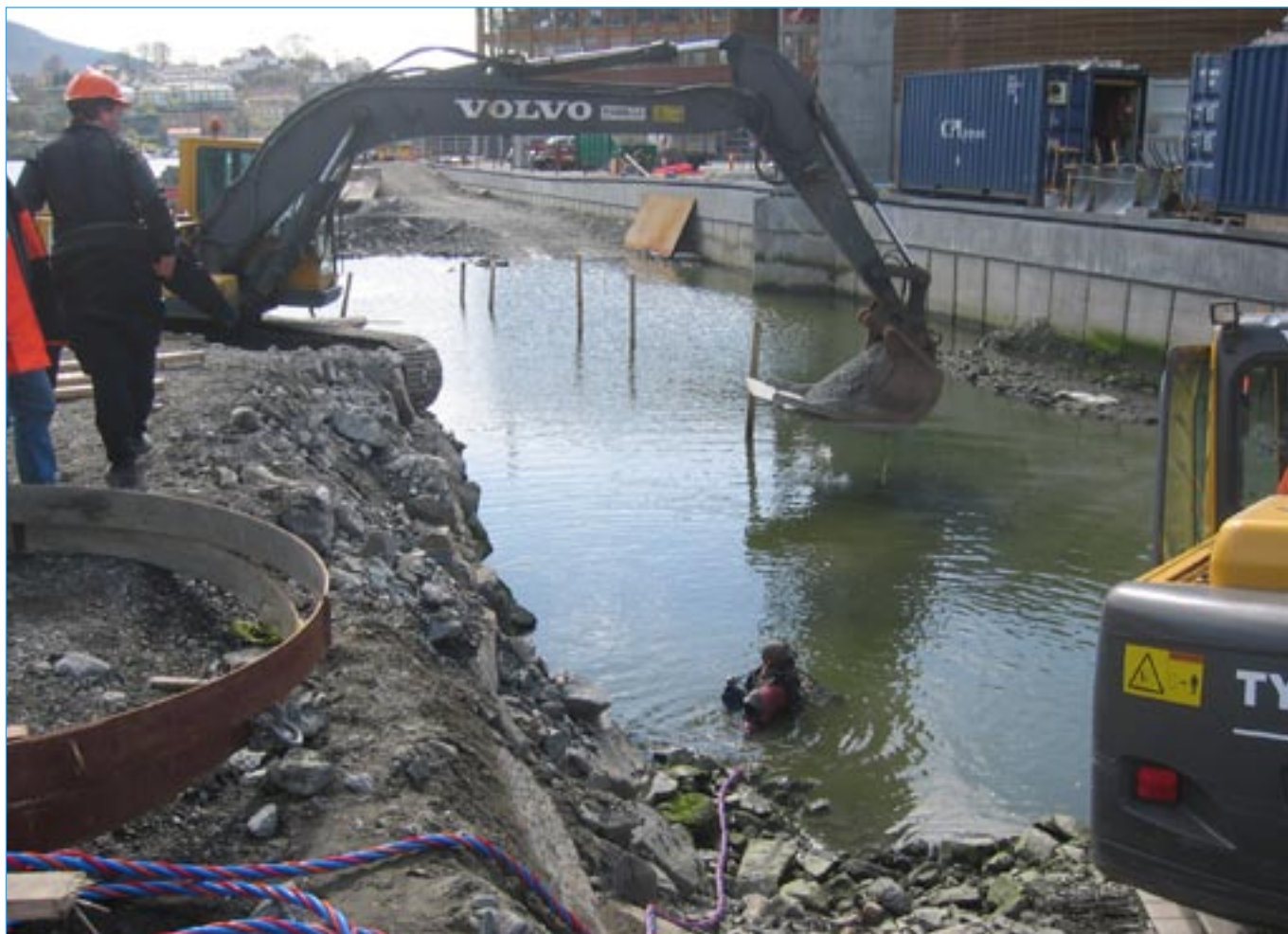
Arbeid på traseen for overvannsledningen
