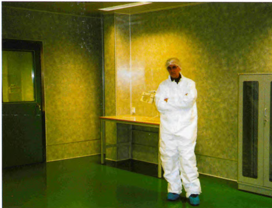
Verksmester Jan Flesland viser frem et av rommene i Sjøforsvarets forsyningskommandos nye "clean room" anlegg. (Foto: A-J Arntzen)
